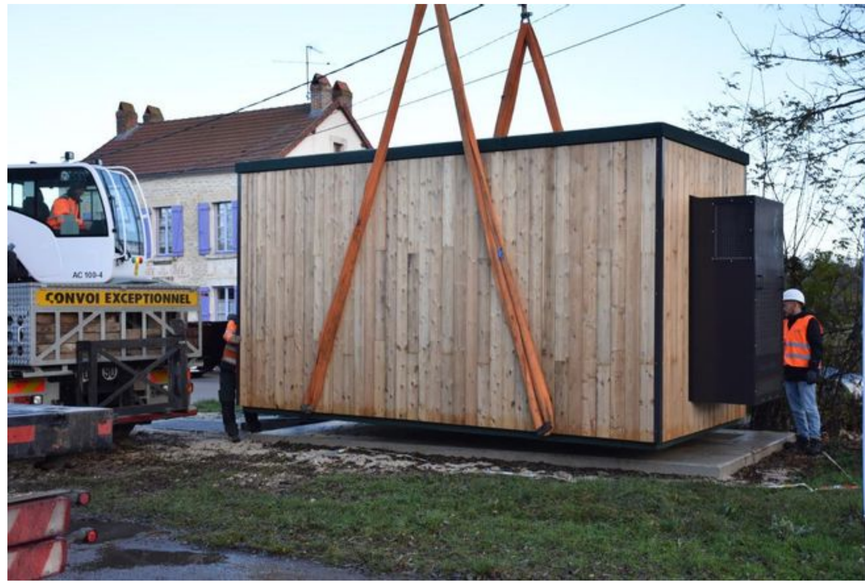
Le 57e et dernier noeud de raccordement optique, équipement faisant le lien entre le réseau national optique et le réseau local, sera mis en service à l'automne à Vézelay. © Delphine Toujas
